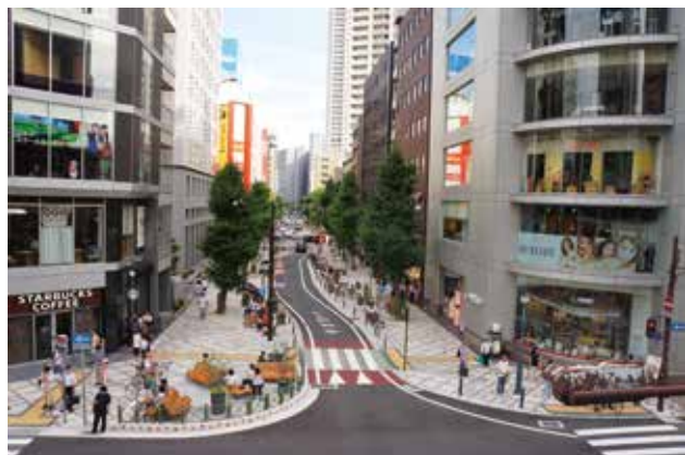
写真-2 葺合南54号線（整備後）
