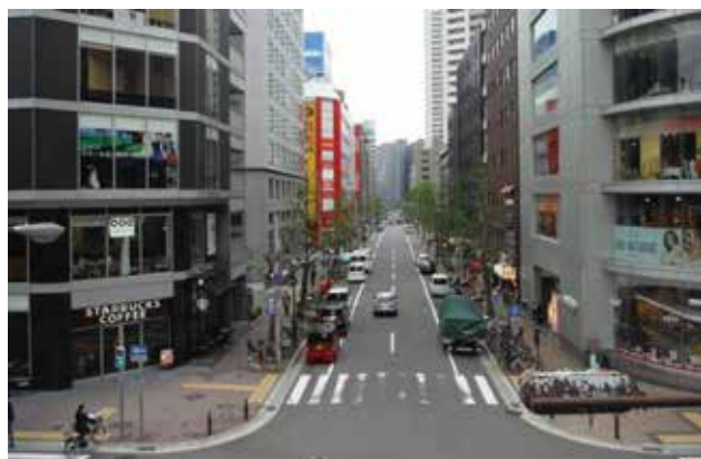
写真-1 葺合南54号線（整備前）
